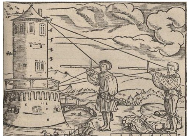
Рис.9. Определение высоты башни с помощью посоха Иакова. Я. Кёбель, 1531
